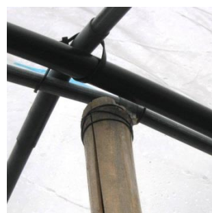
写真5(中央)：鉄パイプを切って上部に固定し、竹を差し込む方法もある
