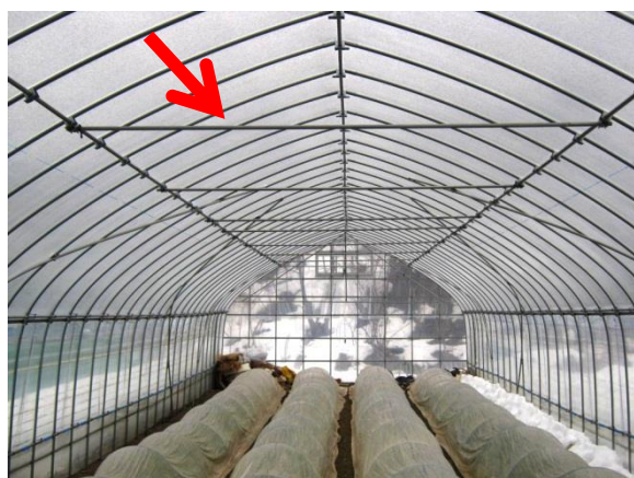
写真7：タイバーの設置例
