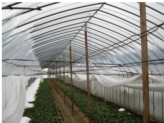
写真1：木材を用いた仮支柱
