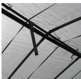
写真4(左)：塩ビパイプを切って上部に固定し、中に木材を差し込む
